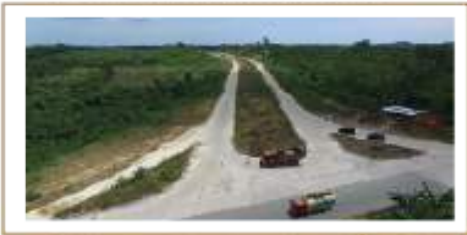
Akses Jalan menuju KEK
